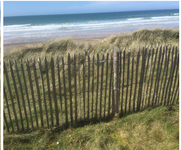
Remise en place des ganivelles arrachées au cours des tempêtes hivernales. Photographie Marie-Léa Travert
