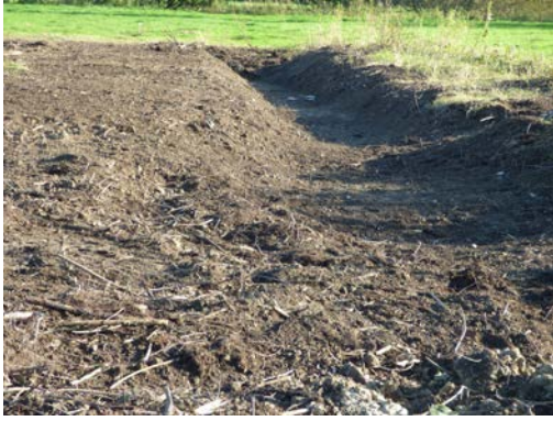
Figure 5 : reprise manuelle de la surface (élimination du reliquat de racines) après extraction des saules (octobre 2020)
